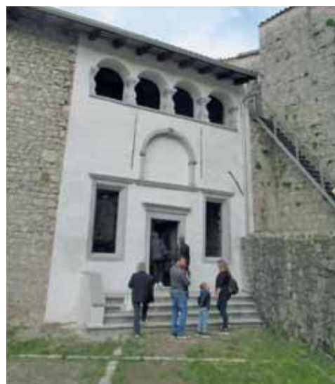
Obnovljena fasada kapele sv. Pankracija.
